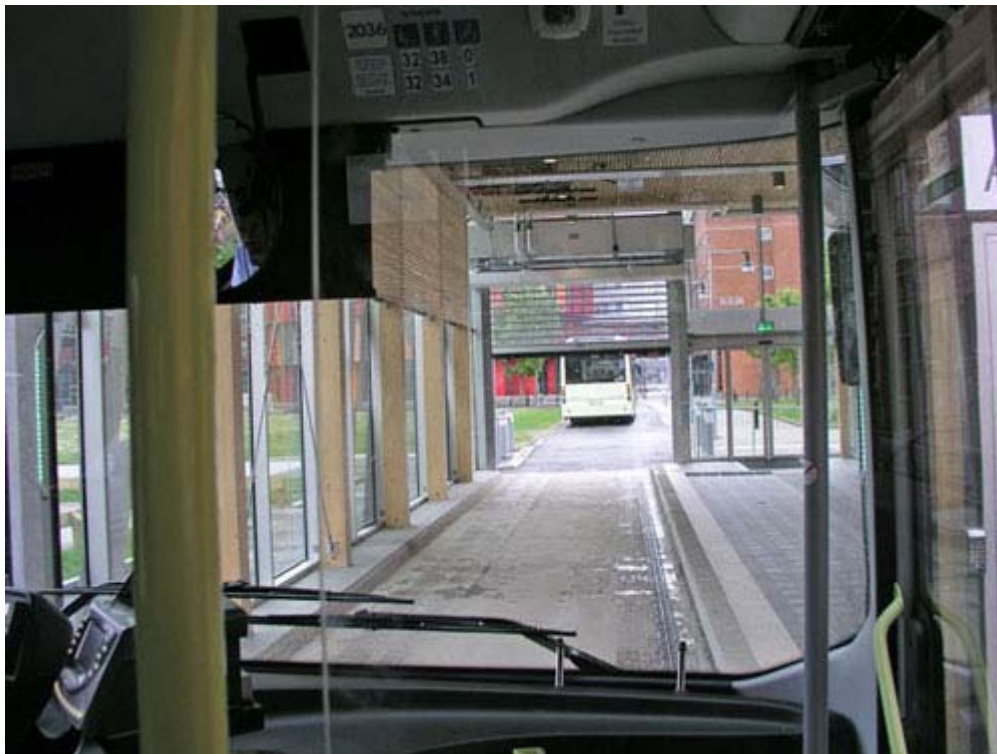
En buss på väg in i laddningshallen medan en annan ger sig av
