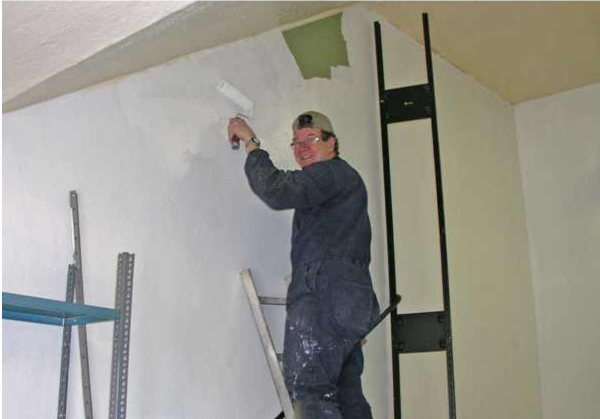
Bengt Lindberg målar väggarna i trapphuset
