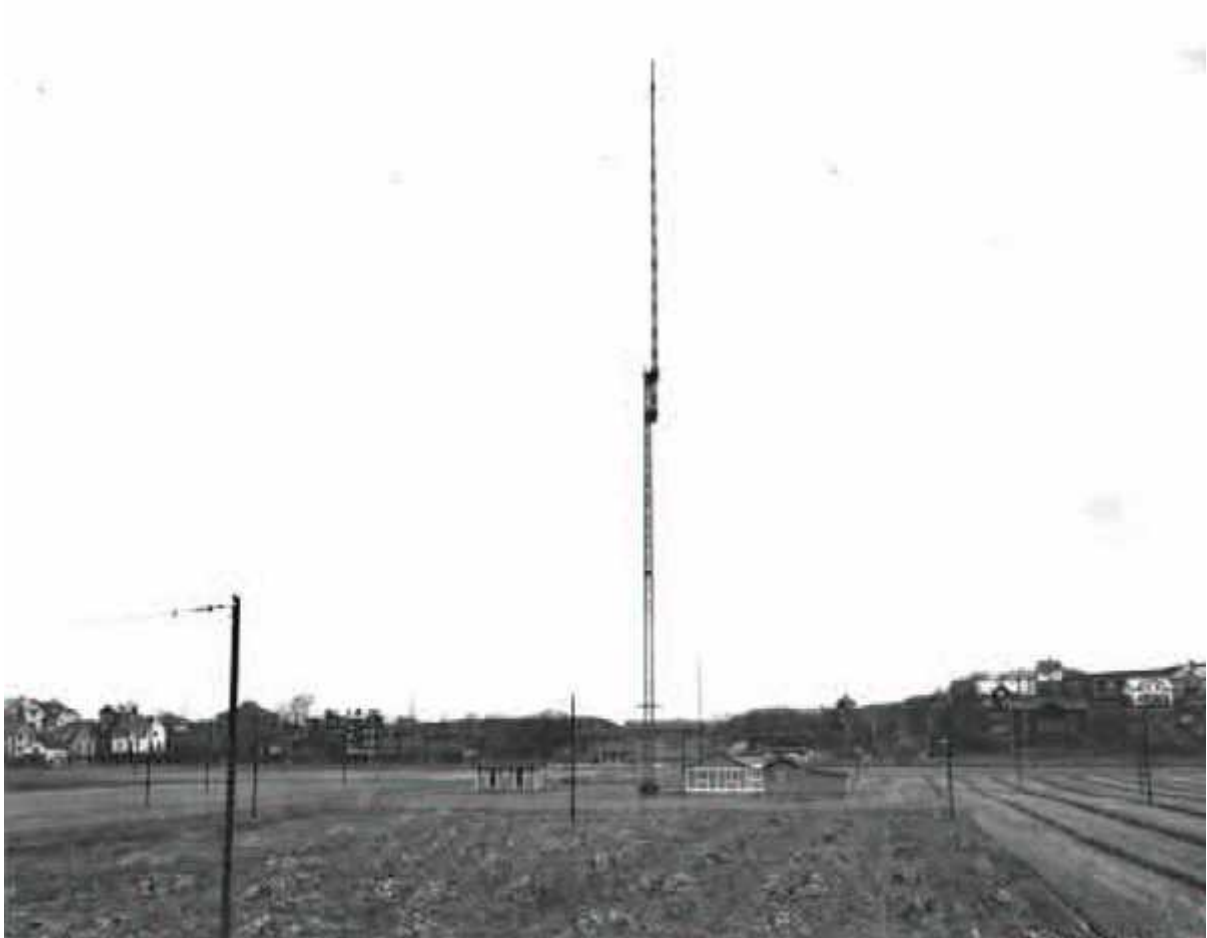
Gnistängen, antennmast och stationshuset 1914
