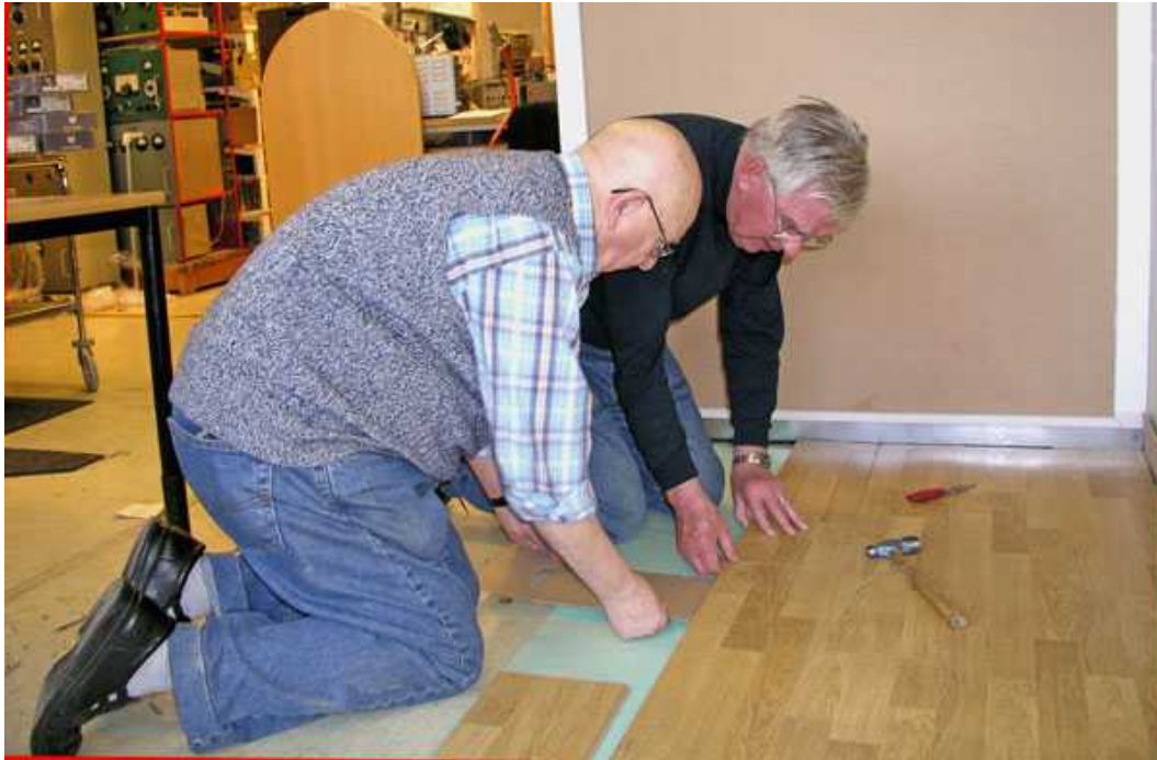
Allan Rosengren och Veine Andersson lägger golv
