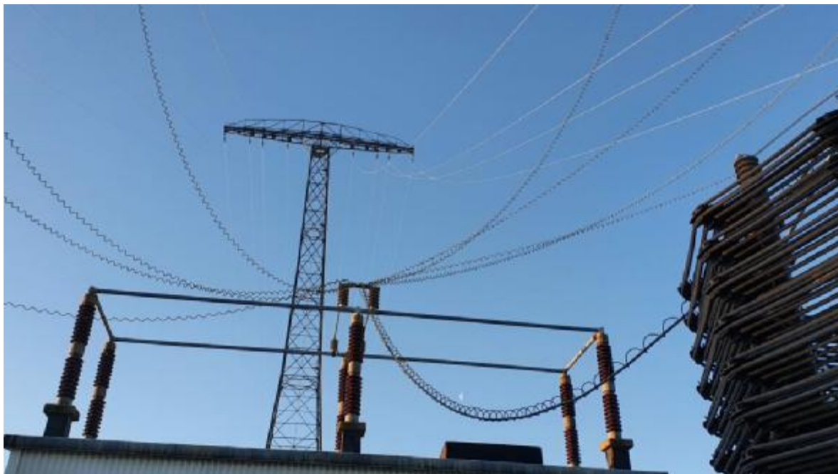
SAQ första antenntornet med sin avstämningsspole.
