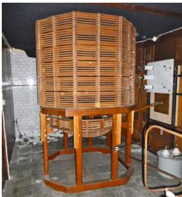
Del av antennavstämningenheten från Kråks radiostation i Karlsborg
