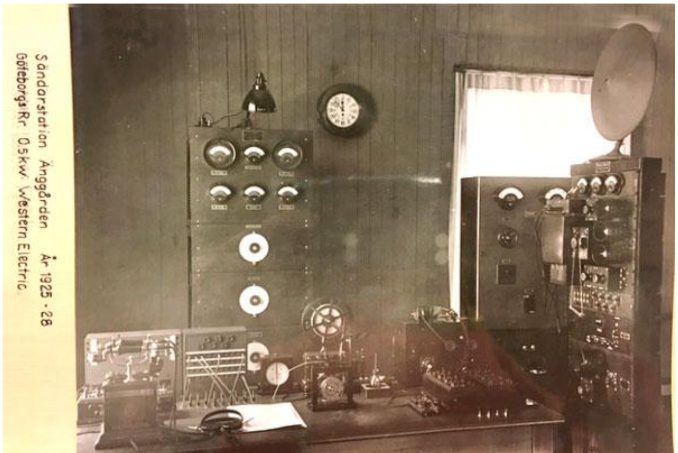
Den första radiosändaren i Änggården på 500 W från Western Electric under åren 1925-28
