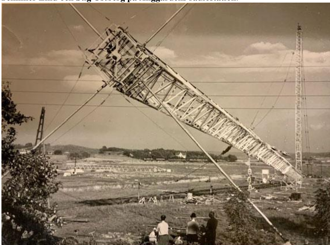
Fällning av ena masten vid rivningen av stationen i november 1953
