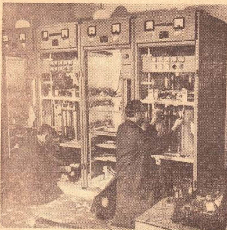
Teleteknikerna Stig Östberg, t. v., och Walter Tenemar håller på med installerandet av FM-sändarna för program 1 och 2.
