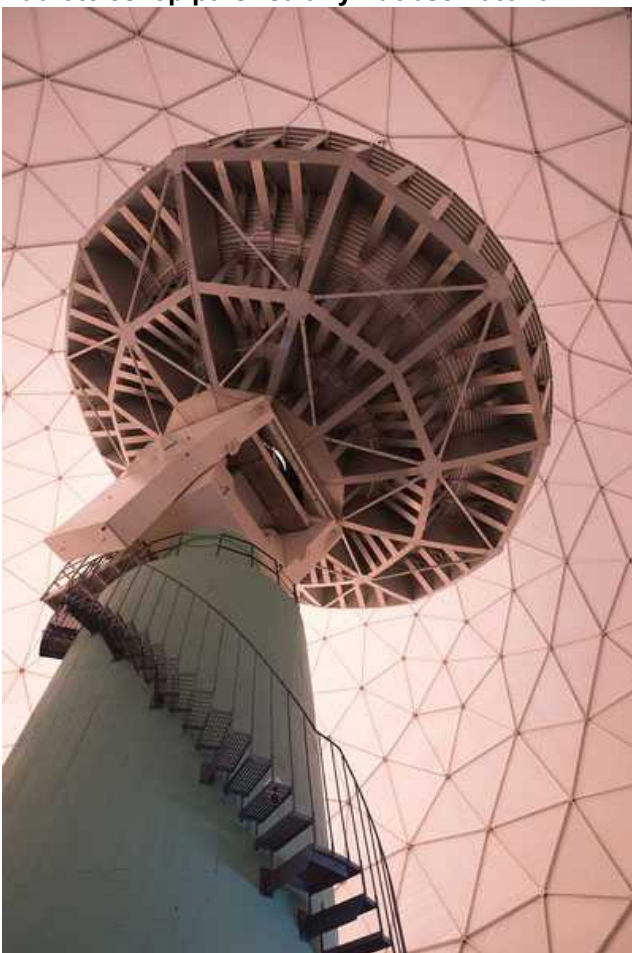
20 m antenn från insidan
